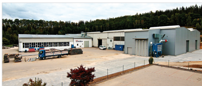
Celkový pohled na areál firmy Metalkov Vlašim – v popředí nové výrobní haly, zprovozněné v roce 2015, s nejmodernější technologií povrchových úprav s maximální šetrností k životnímu prostředí. (Foto: Archiv Metalkov Vlašim)
