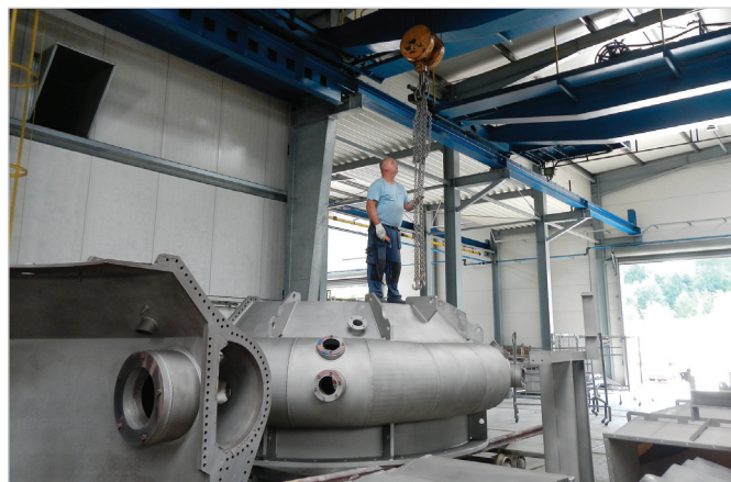
Skříň turbíny před aplikací antikorozní úpravy
