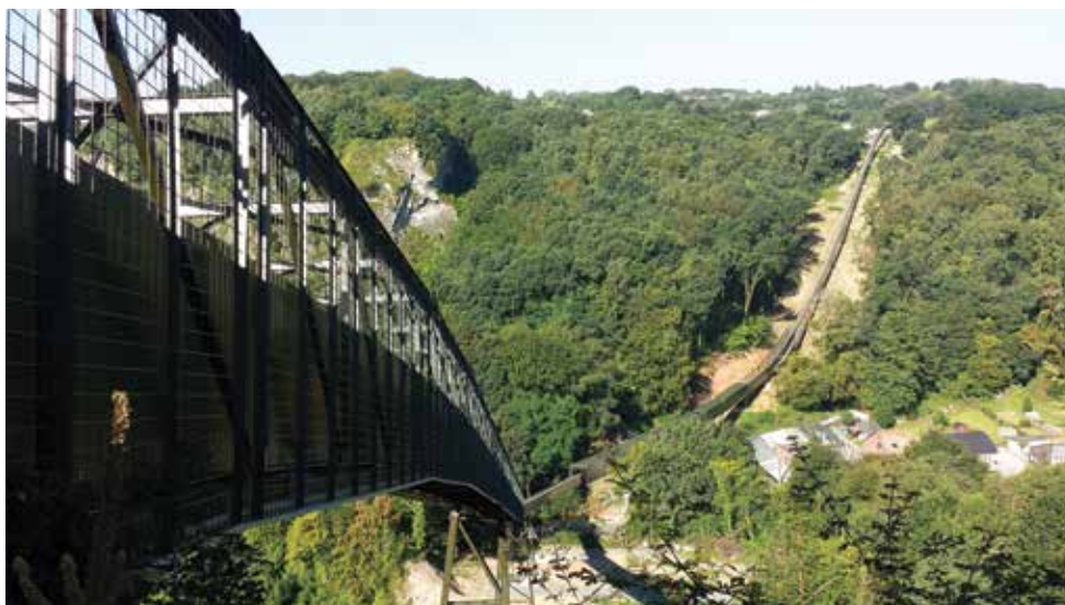
Obr. 2 - Trubkový přepravník sypkých hmot pro belgickou elektrárnu Engie-Electrabel. Zakázka v objemu 600 tun oceli byla přepravovaná na 93 nákladních kamionech
