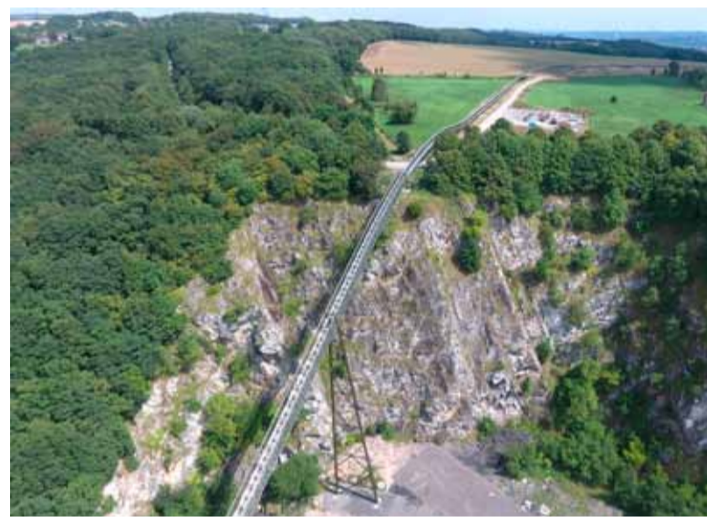
Obr. 1: Příhradový pásový dopravník povrchově upravovaný v minulosti pro klienta v Belgii
